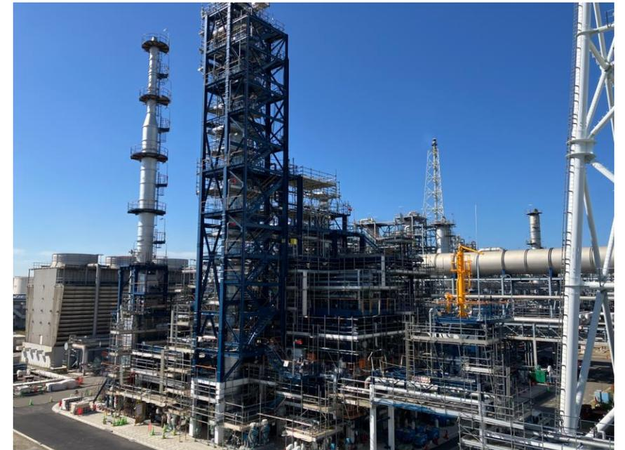
ニートSAF製造装置（左：加熱炉、中：蒸留塔）
