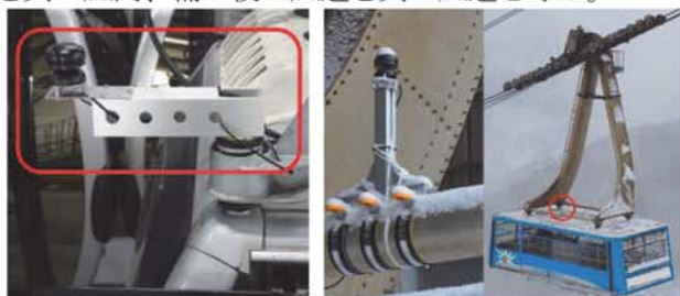
図5 A路線の取り付け状況(左)、 B路線の取り付け状況(右)
